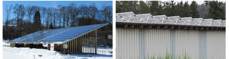
Abb.2: Solaranlagen parallel und aufgeständert zur Dachebene.
